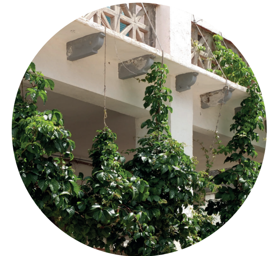
F1 La bastida i el filtre de cordes com a estratègia principal d'intervenció.
