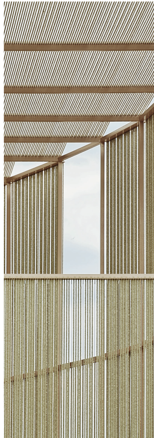
F1 La bastida i el filtre de cordes com a estratègia principal d'intervenció.
